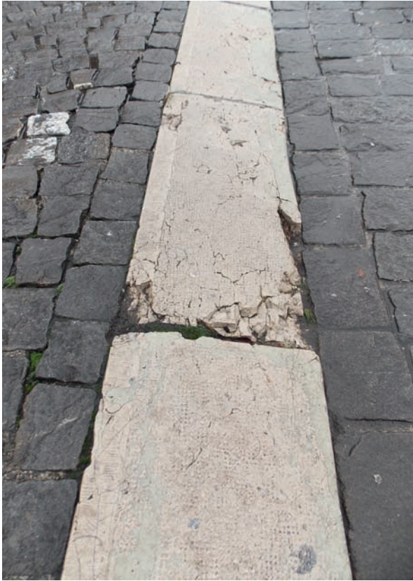
Randstein aktuelle Situation
