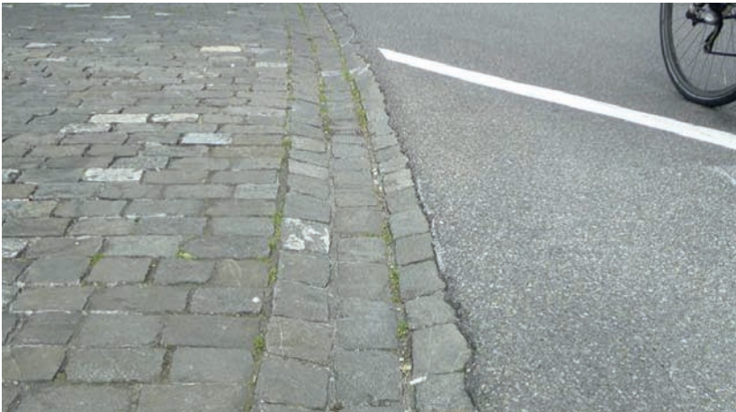
Bestehende Entwässerungsschale
